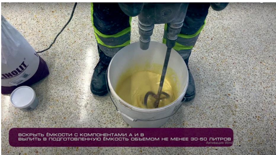
2. Постепенно внести наполнитель (компонент С) в смесь, мешать в течение минимум 2 минут до полного перемешивания и получения гомогенной (однородной) смеси. Рекомендуемое время смещивания 2-3 минуты. Особое внимание следует уделять тщательному перемешиванию материала в зоне дна и стенок ведра во избежании дефектов покрытия (плохо перемешанные компоненты и комки сухой смеси не полностью вступают в химическую реакцию).
